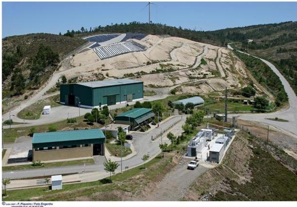
Figura 4.17 – Aterro Sanitário de Penafiel. ( http://www.ambisousa.pt )
